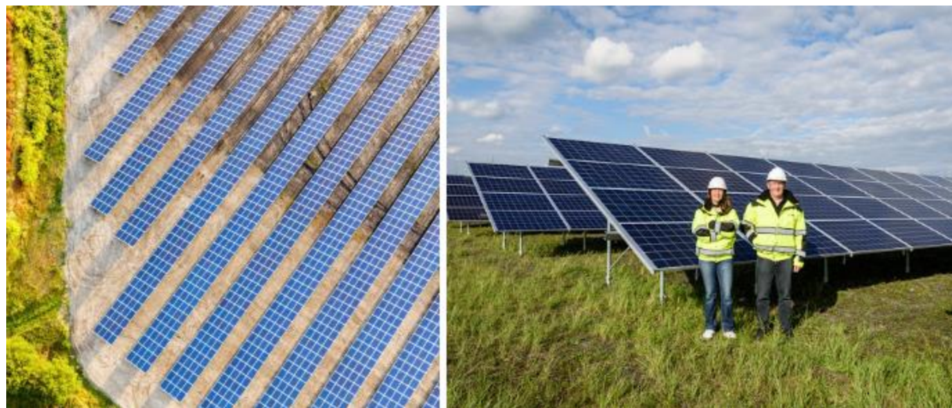
2017년 벨기에 St. Ghislain 구글 데이터 센터에 대규모의 태양광 패널 설치
